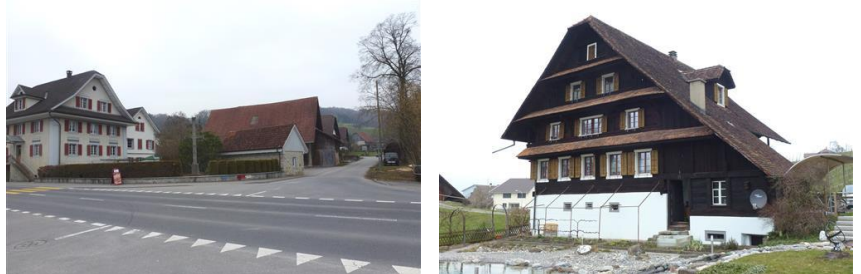
Abbildung 3: Baugruppe A «Donastrasse» (links) und schützenswertes Bauernhaus mit Baujahr 1807 (rechts), Quelle: Bauinventar des Kantons Luzern
