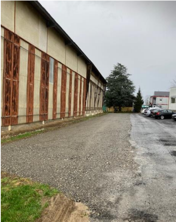
Abbildung 4: Aktuelle Situation nach Einbau Kiesschicht
