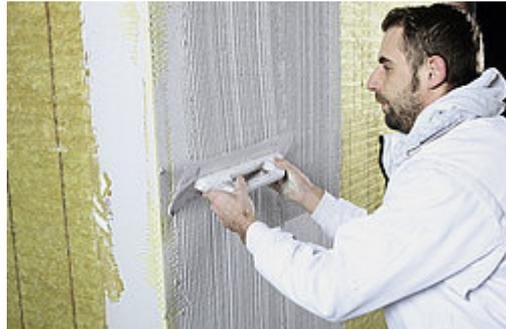
Zweischichtige Dämmplatte mit spezieller Oberfläche und guter Putzhaftung für verputzte Aussenwärmedämmsysteme.
