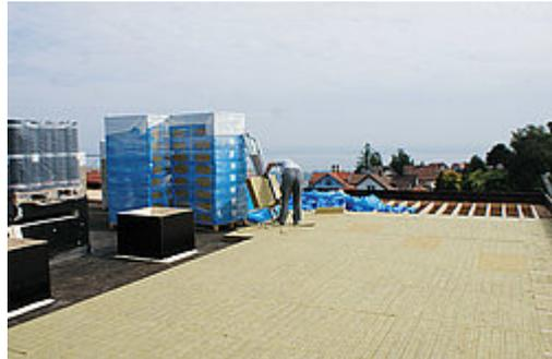
Zweischichtige Dämmplatte für den Einsatz in Flachdächern, welche nur beschränkt für den Unterhalt begehbar sind. Auch als Gefälledachlösung erhältlich.
